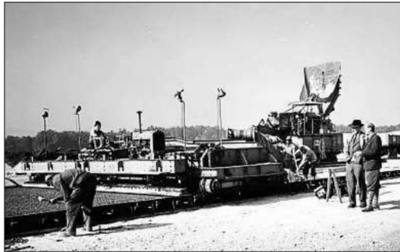
Die jetzige Betonpiste wurde 1960 gebaut und seither immer wieder aufwändig saniert.
