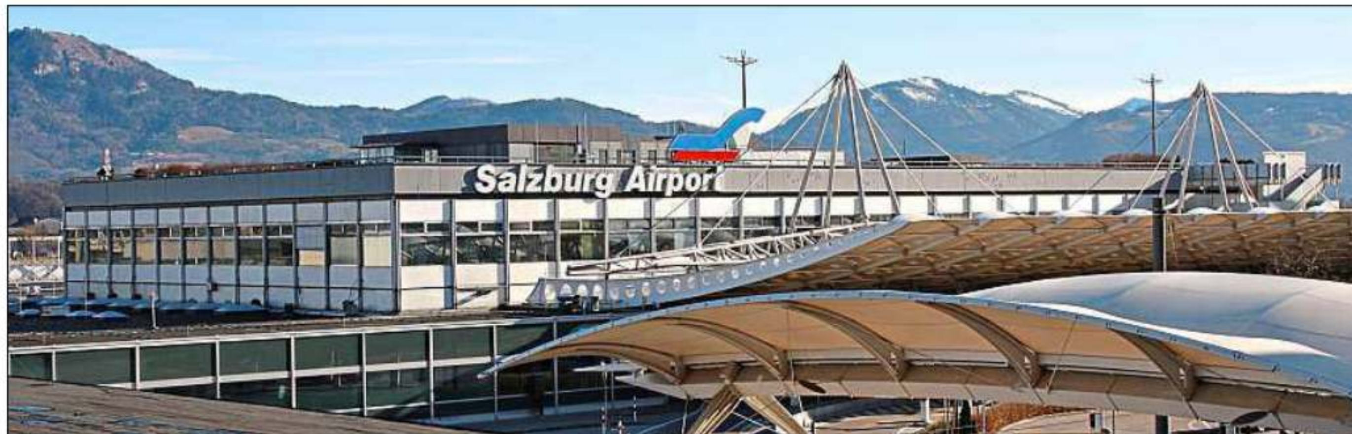
Inzwischen über 60 Jahre alt: Das Terminal 1 des Flughafens Salzburg.
