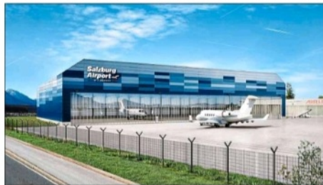
Der neue rund zehn Millionen Euro teure Hangar 1 verbindet laut Airport eine funktionale Bauweise mit einer markanten Gestaltung. – F.: Airport
